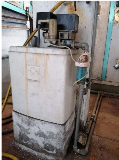
Foto: addolcitore e canalizzazioni esterne da sostituire
